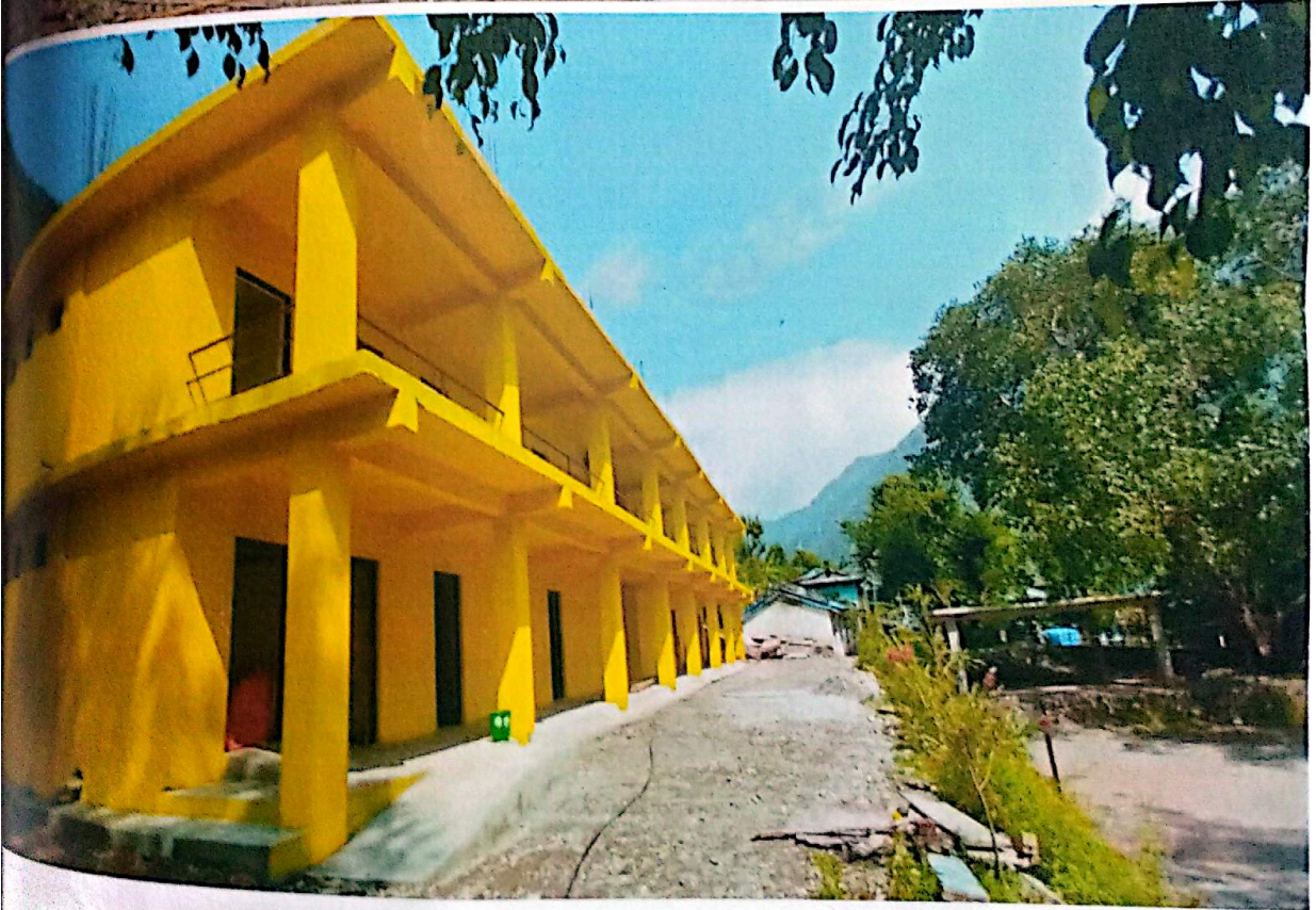
श्री जनता माध्यमिक विद्यालय पोखरा भवन निर्माण
